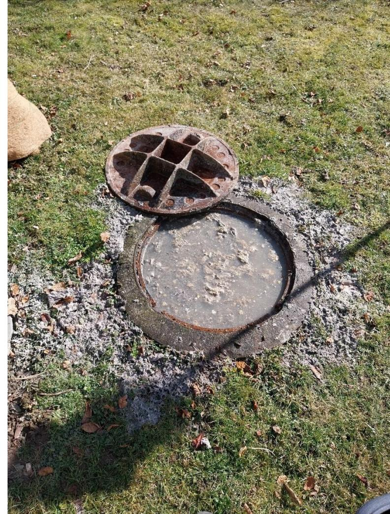
Feststoffe verlegen das Schneidrad der Pumpe, ein abpumpen des Abwassers ist nicht mehr möglich! Die Pumpe ist nicht mehr zu reparieren.
