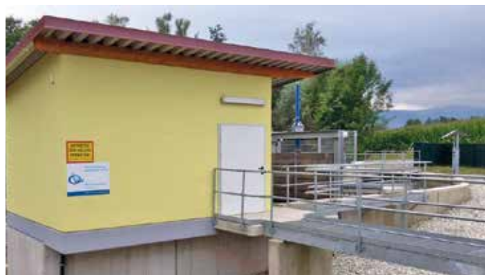
E-Werk an der bestehenden Wehranlage
