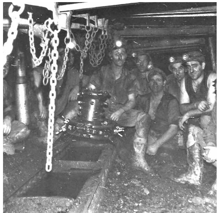
Arbeiten im Streb
