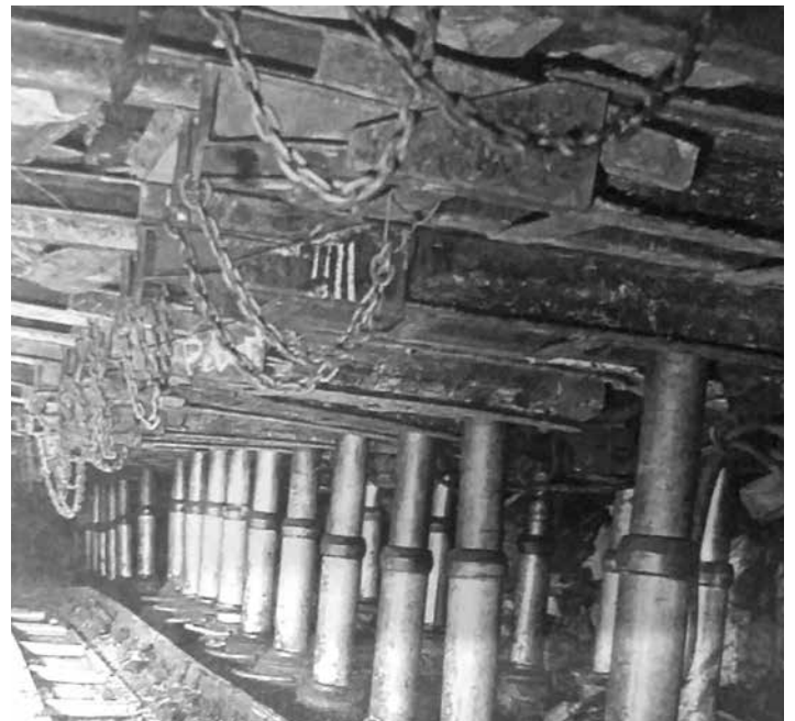
Kettenförderer „Westfalia PF 0“; Zeltweger hydraulische Ausbauböcke
