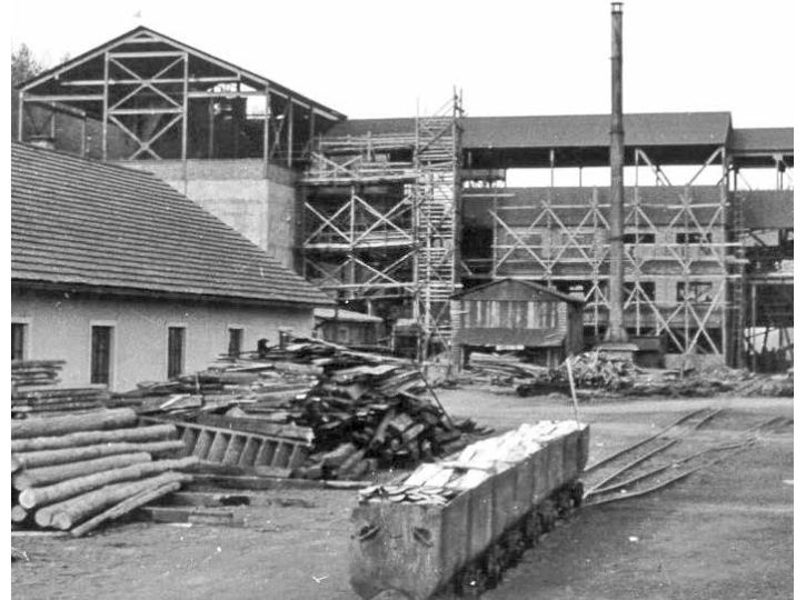
Bau der neuen Sortierung 1954
