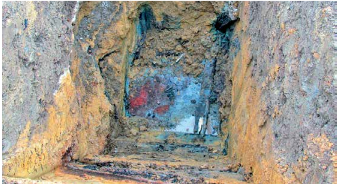
Schurfschlitz beim ehemaligen Tombach I Gesenke TÖ 214 GKB GmbH
