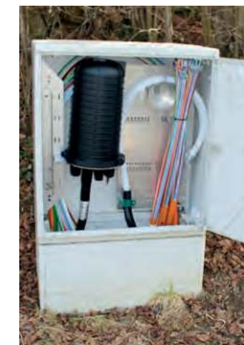
Vom POP-Standort aus werden die FCP-Kästen bereits mit Glasfaser versorgt.
