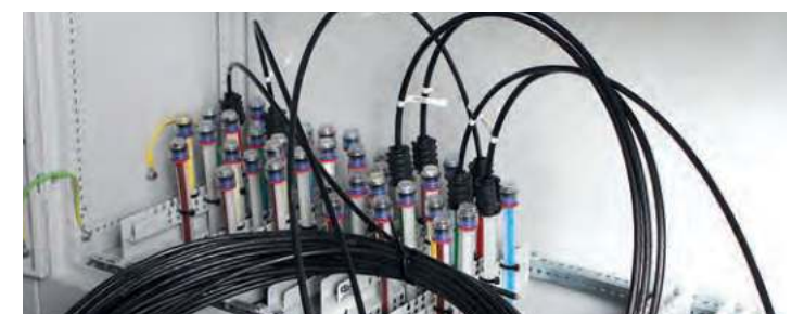
Vom POP-Standort aus werden die FCP-Kästen bereits mit Glasfaser versorgt.
