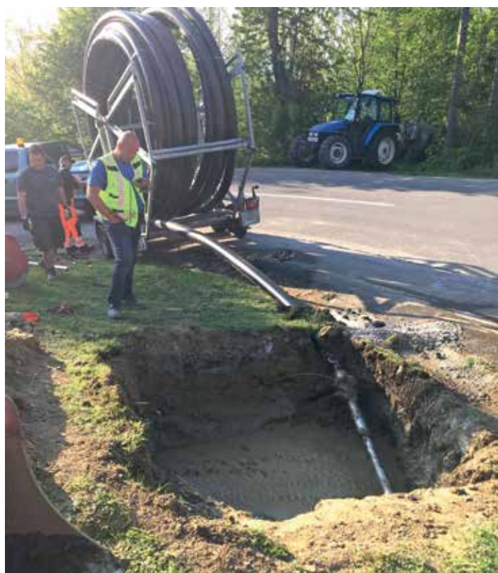
Mit der Spülbohrung wurde das Aufgraben und Beschädigen der Landesstraße vermieden. So wurde nur am Straßenbankett aufgedigelt.
