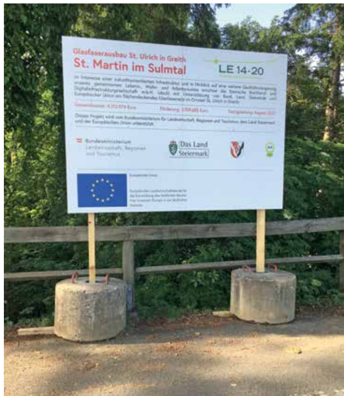
Am Rosenberger Parkplatz wird ein Container als zentraler Anschlusspunkt des Glasfaserausbauers errichtet.
