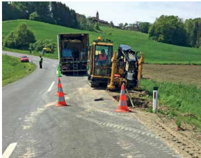
Mit der Spülbohrung wurde das Aufgraben und Beschädigen der Landesstraße vermieden. So wurde nur am Straßenbankett aufgedigelt.
