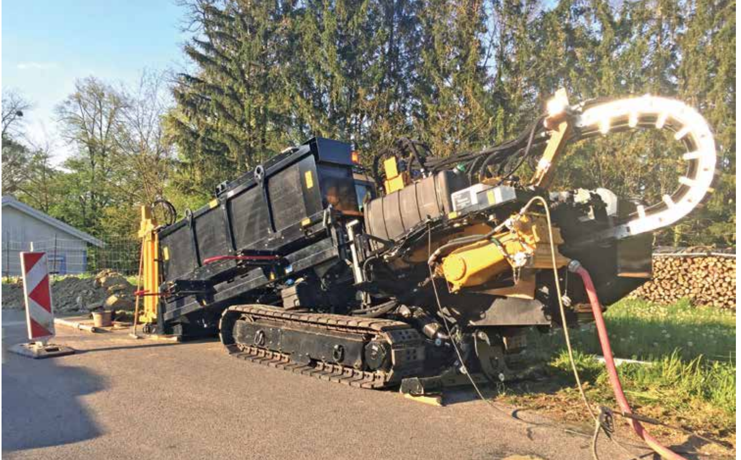
An der Landesstraße wurden die Spülbohrungen erfolgreich und zügig durchgeführt.
