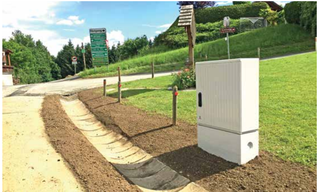
Die Aufstellungen der Verteilerkästen im gesamten Ausbaubereich sind erledigt.
